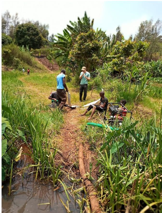
Das Wasser muss von einer Distanz von circa 600 m entfernt gepumpt werden, allerdings die bergauf und mit einem Steigungsgrad von 30%. Hierfür müssen die Wasserleitungen (Feuerwehrschräume) jedes Mal ausgelegt werden und danach wieder zusammengerollt werden, da die Diebstahlrate in Kenia sehr hoch ist.
